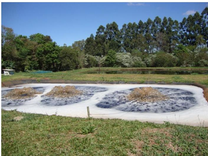
**Figura 14: Sistema de aeração das lagoas de tratamento de chorume no aterro sanitário.**
