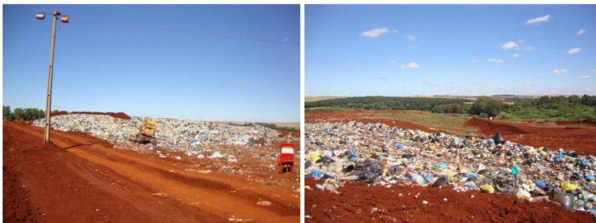
**Figura 11: Célula do aterro sanitário em fase final de operação.**
