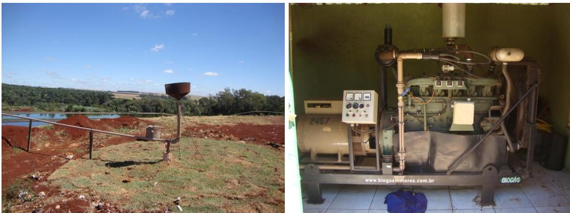
**Figura 13: Sistema de captação de gás e gerador de energia elétrica.**
