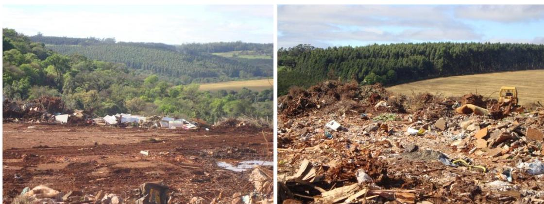
**Figura 40: Resíduos volumosos e verdes dispostos no aterro de inertes sendo compactados com trator de esteiras.**
