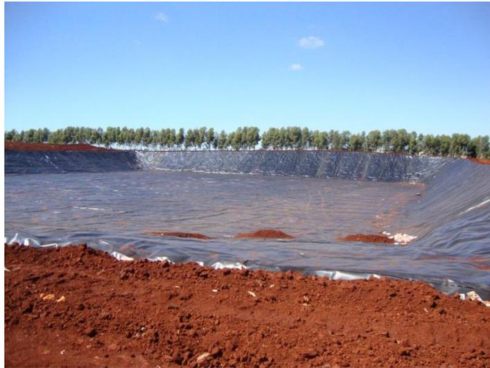
**Figura 12: Nova célula do aterro sanitário em construção.**
